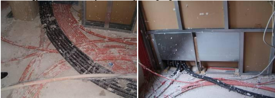
38-39. ábra: A földemen futó vezetékek takarásához kiegyenlítő esztrich tervezése szükséges
