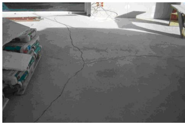
42. ábra: A 10 \text{ kN/m}^2 megoszló terhelést is eredményező raklapos termékek építésközbeni felhalmozása, kemény kerekű kézi eszközzel való szállítása miatt az úsztatott esztrich megrepedhet
