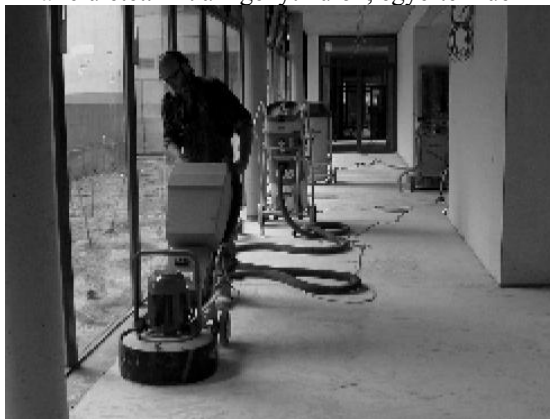
10. ábra: Az esztrichfelület csiszolása burkolás előtt
