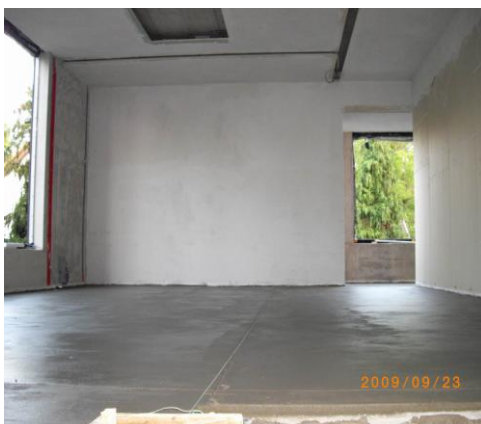
41. ábra: A megfelelően elkészített esztrich is megrepedezhet huzatos körülmények között
