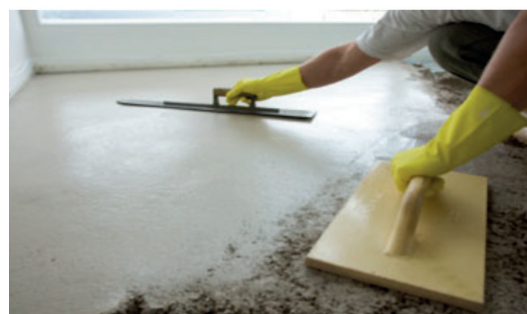
19. ábra A péppel telítetlen vagy enyhén túltelített földnedves cementesztrich kézi lehúzása léccel (fölül) és kézi simítása (alul)
