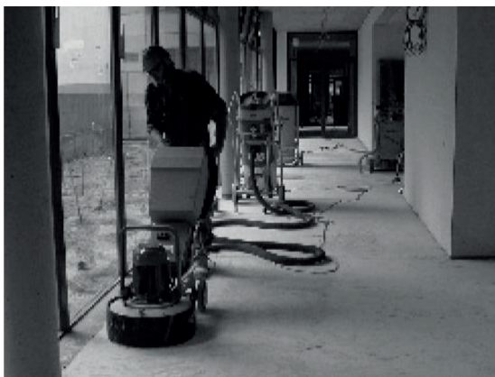
10. ábra Az esztrichfelület csiszolása burkolás előtt
