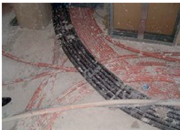
37-38. ábra A födémen futó vezetékek takarásához kiegyenlítő esztrich tervezése szükséges
