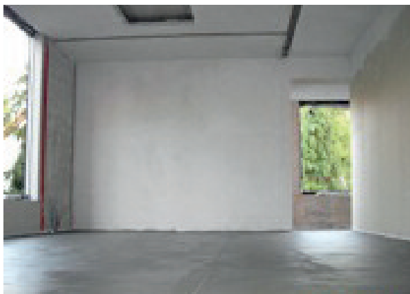
40. ábra A megfelelően elkészített esztrich is megrepedezhet huzatos körülmények között
